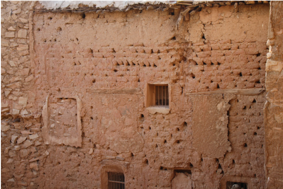
Abb. 2.22: Koy Sanjaq, Autonome Region Kurdistan, Irak, heutiges Beispiel für die Verwendung von Holzarmierungen im Mauerwerksbau (Foto: D. Kurapkat 2012).
