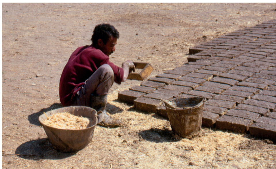
Abb. 2.15: Lehmziegelherstellung im heutigen Ägypten (Foto: D. Kurapkat 2001).
