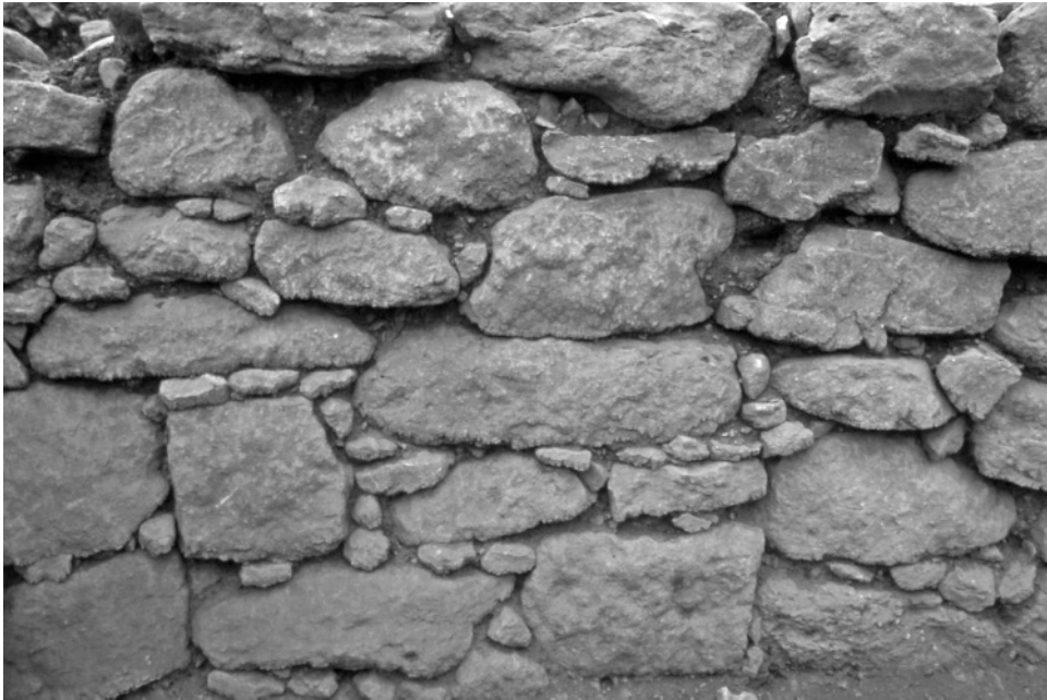
Abb. 2.8: Göbekli Tepe, Anlage C frühneolithische Bruchsteinmauer mit ‚Auszwickungen‘ durch kleine Füllsteine (Foto: D. Kurapkat/DAI 2000).
