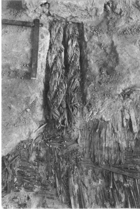
Abb. 3.38: Schilfrohlage und Doppeltau aus gedrehtem Schilf im Lehmziegelmassiv der Zikkurraat des Urnammu im Eannabezirk von Uruk/Ur III-Zeit. Photo: DAI, Orient-Abteilung, Photo-Nr. W000597.
