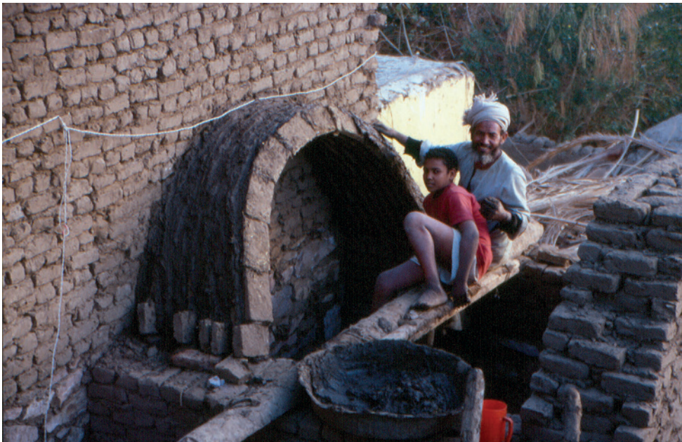
Abb. 2.31: Generationsübergreifender Wissenstransfer – „training on the job“ – beim Bau von sog. Nubischen Gewölben auf der ägyptischen Nilinsel Elephantine (Foto: D. Kurapkat 2001).
