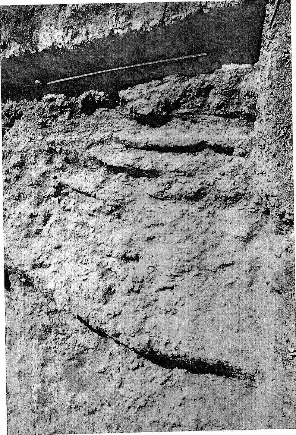
Şekil (7) o 23, kat 2'den kerpiç duvar içinde tahta hatıl kalıntıları.
